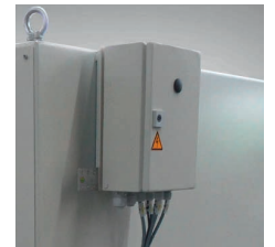
Caja de bornes / interruptores Terminal-/switch box
