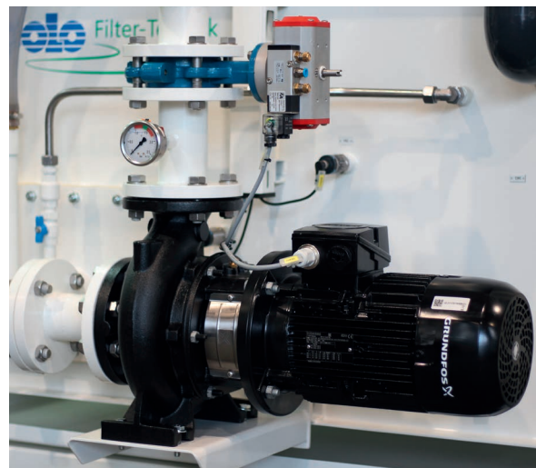
Bomba de descarga / Discharge pump
